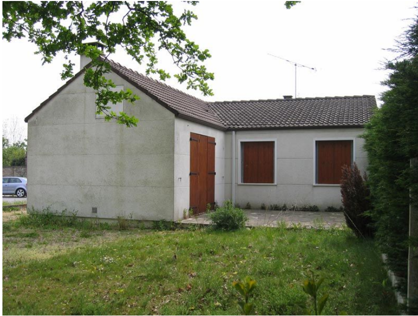
Maison de Saint-Fargeau avant travaux
