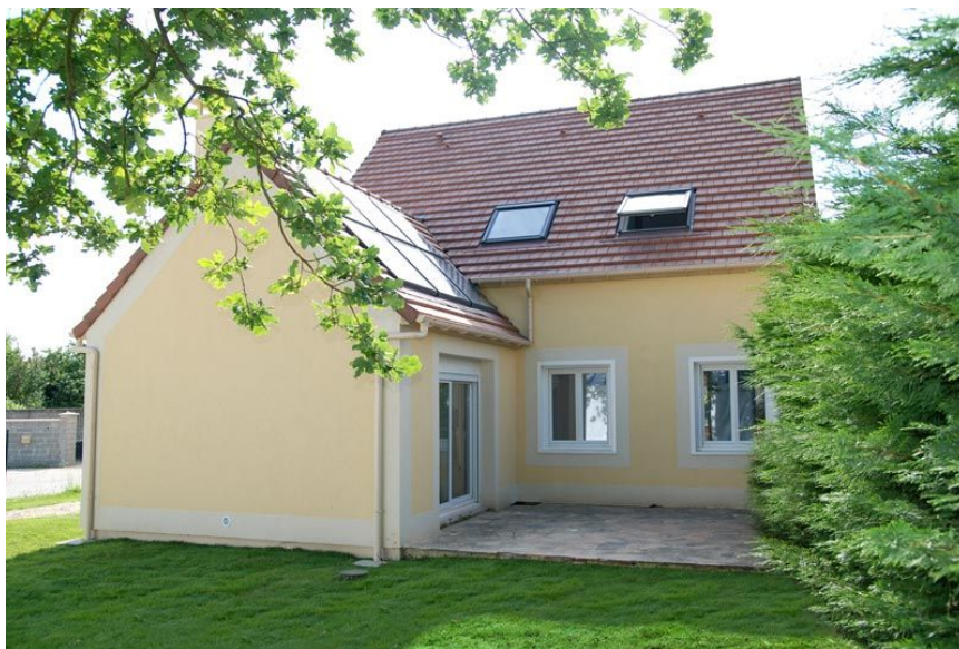
Maison de Saint-Fargeau après travaux
