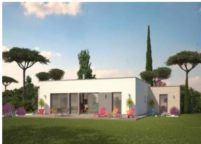
Plain-pied, toiture plate - Sud Crédit photo : Phénix
